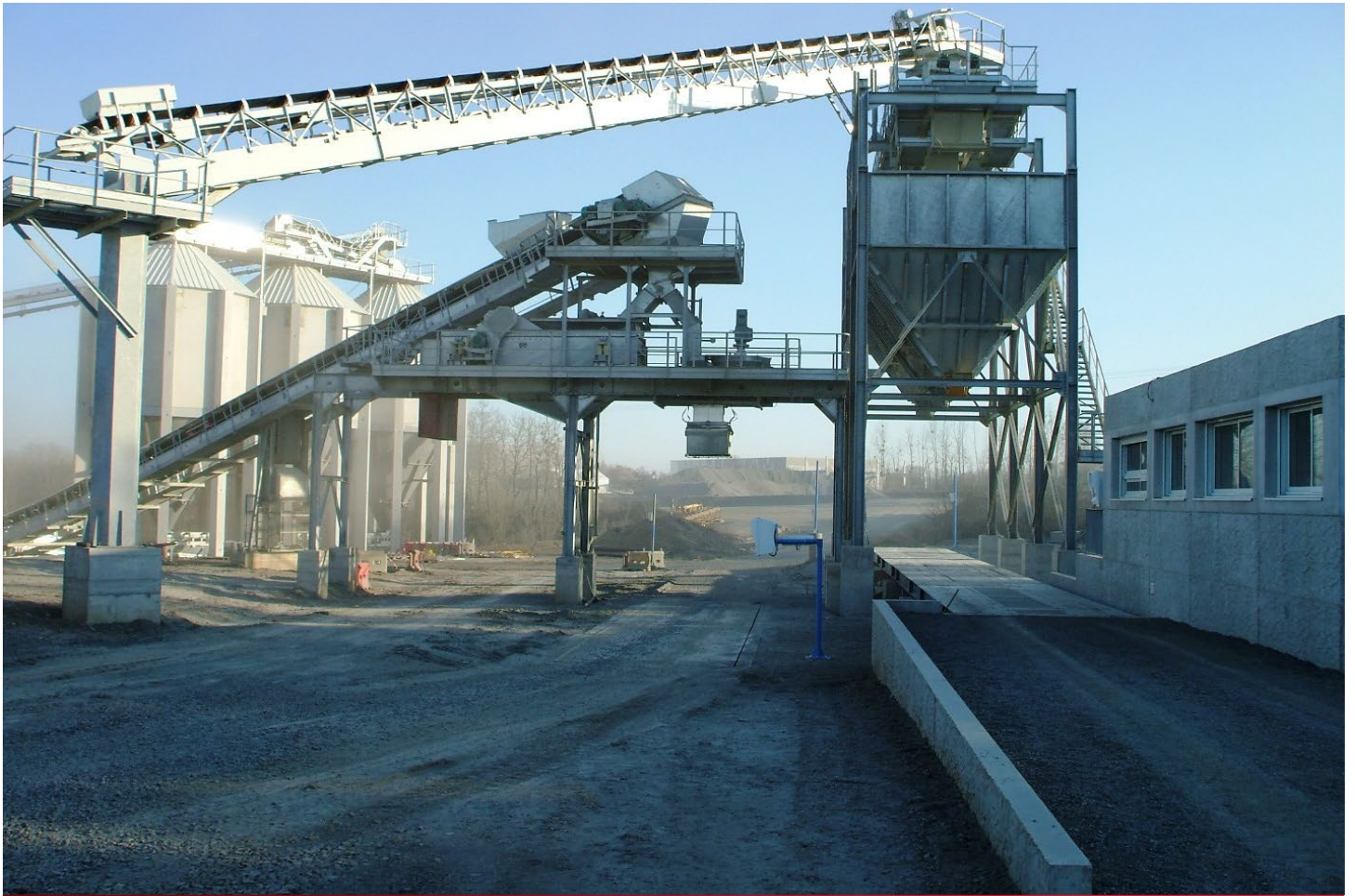
PESAGE SOUS SILOS ET CONTROLE D'ACCES
