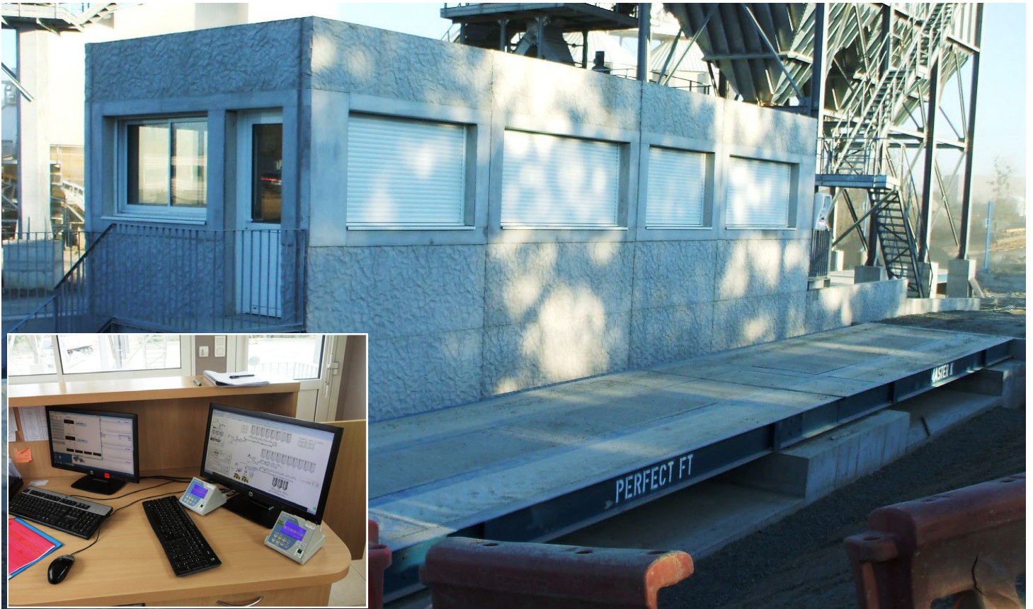
PONT-BASCULE D'ENTRÉE ET LOCAL DE GESTION PROCESS
